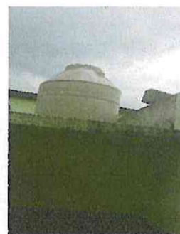
Foto 4: U sustitución de depósito de agua 1000L
