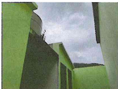
Foto 1: M2 reparación de muro perimetral
