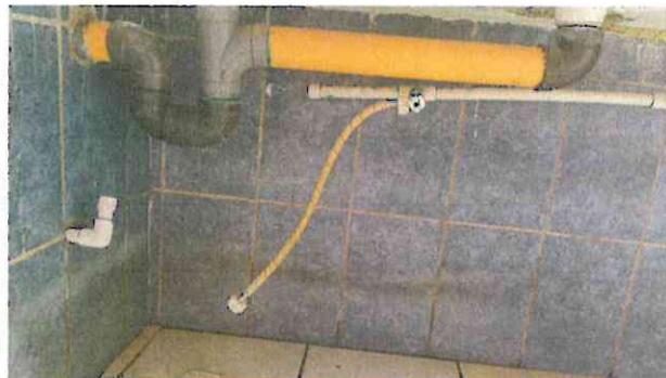
Foto 2: U. sustitución de sanitarios y accesorios
