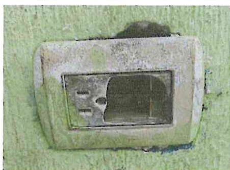
Foto 5: U. sustitución de tomacorrientes (salones cocina sanitarios corredores y aulas)
