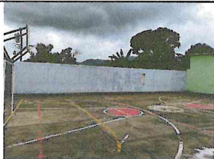
Foto 3: M2 Pintura en muros exteriores e interiores (salones cocina corredores)
