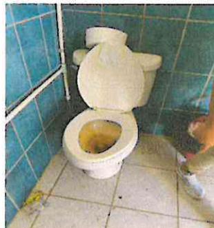
Foto 2: U sustitución de baño y accesorios
